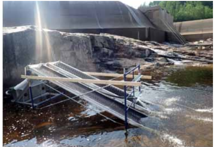
Figure 4 : Exemple de passe-piège à anguilles érigé sur la Côte-Nord pour le MFFP. Photo : Alian Gros-Louis Picard
