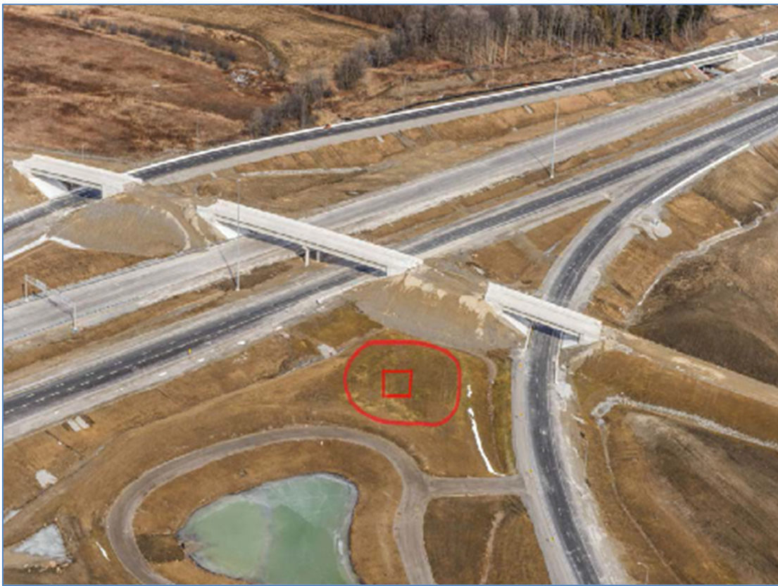
Emplacement de l'œuvre à installer.
